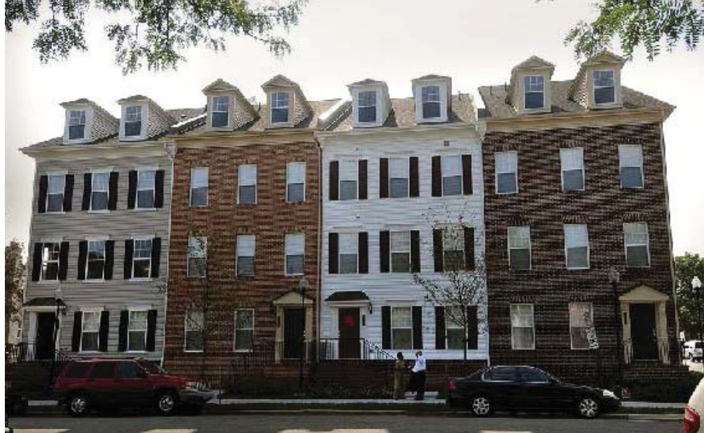
Flats; four story, 2 unit flats
