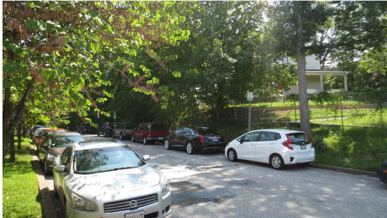
EXISTING SITE CONDITION - P ST., SE
