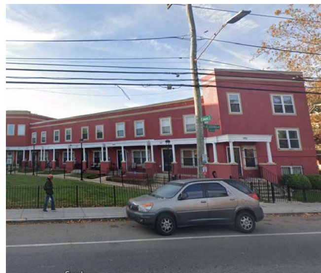
F | 1427-1413 ALABAMA AVE. SE
