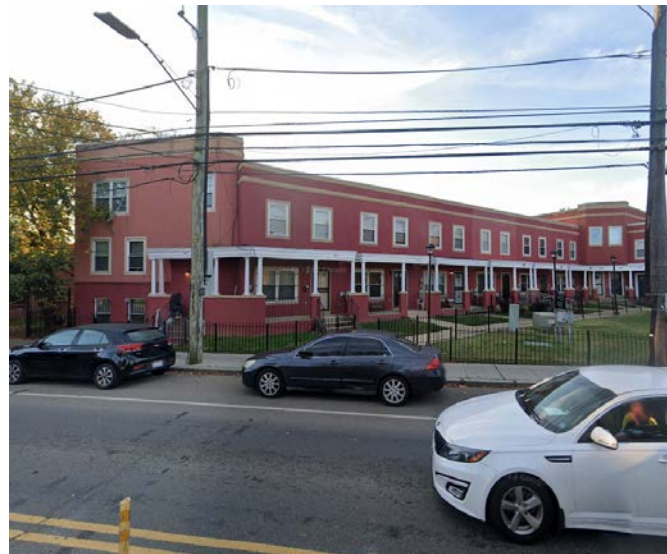
E | 1441-1429 ALABAMA AVE. SE
