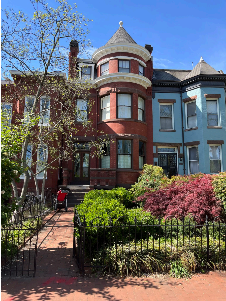
718 N. Carolina Ave SE street frontage
