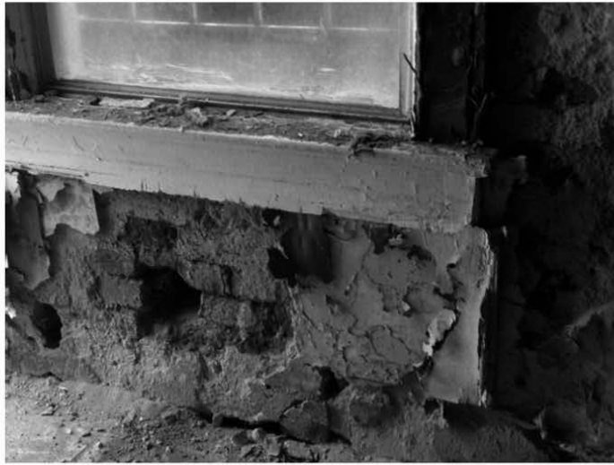
Fig. 3 Mortar Deterioration
