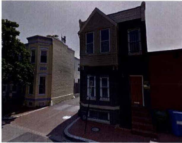
1 SITE PHOTO SCALE: N.T.S.
