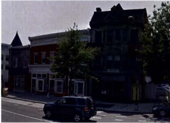
1 SITE PHOTO SCALE: N.T.S.
