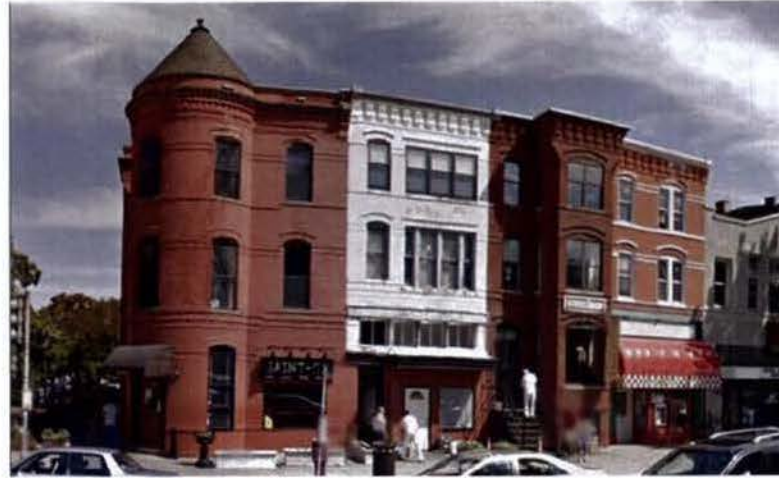
2 SITE PHOTO SCALE: N.T.S.
