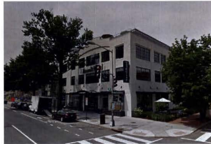
4 SITE PHOTO SCALE: N.T.S.
