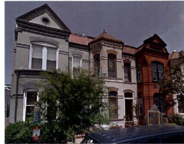
2 SITE PHOTO SCALE: N.T.S.
