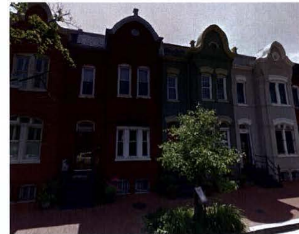
4 SITE PHOTO SCALE: N.T.S.
