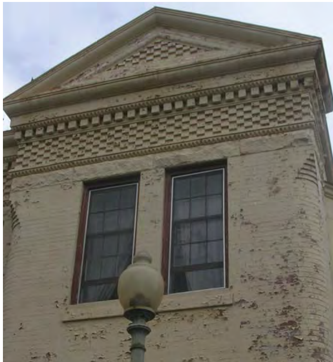
3 SITE PHOTO SCALE: N.T.S.
