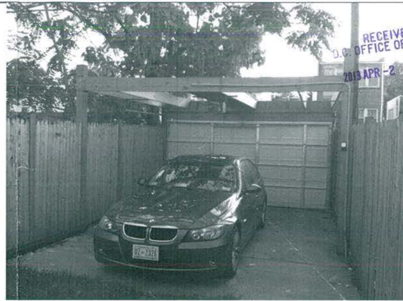
2 803 9TH STREET SE EXISTING STRUCTURE C-4 SCALE: N.T.S.
